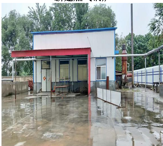
封闭厂房降噪
